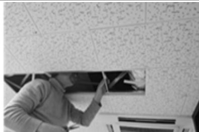
〈냉난방기 서브 덕트 설치〉
